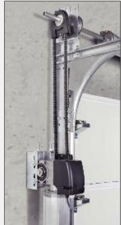
Kettenantrieb Bei beengten seitlichen Platzverhältnissen ist der Einsatz von platzsparenden Kettenantrieben empfehlenswert.
