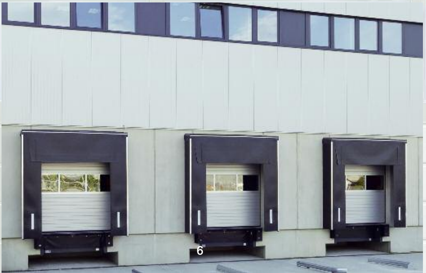
Sectionaltor SW mit Lichtband im Bereich der Verladetechnik.
